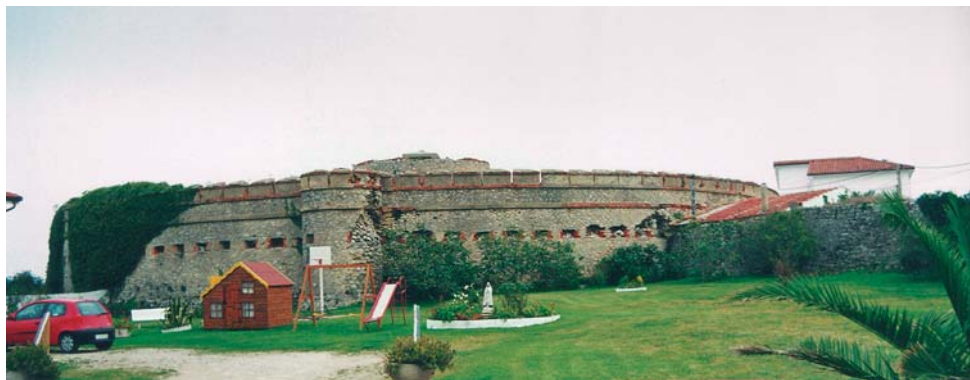
Estado actual del reducto de La Corbanera, apreciándose una de las caponeras, la terraza de la torre central y el arranque de una de las cortinas aspilleradas (a la derecha). Fotografía de Rafael Palacio Ramos.
